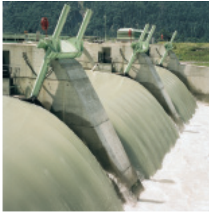
Tiroler Wasserkraftwerke AG, A-6010 Innsbruck
